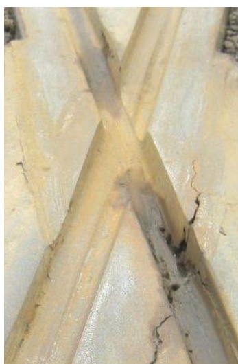
8. Widok rzeczywisty (z lewej) i cyfrowy bliźniak (z prawej) krzyżownicy tramwajowej [11]
