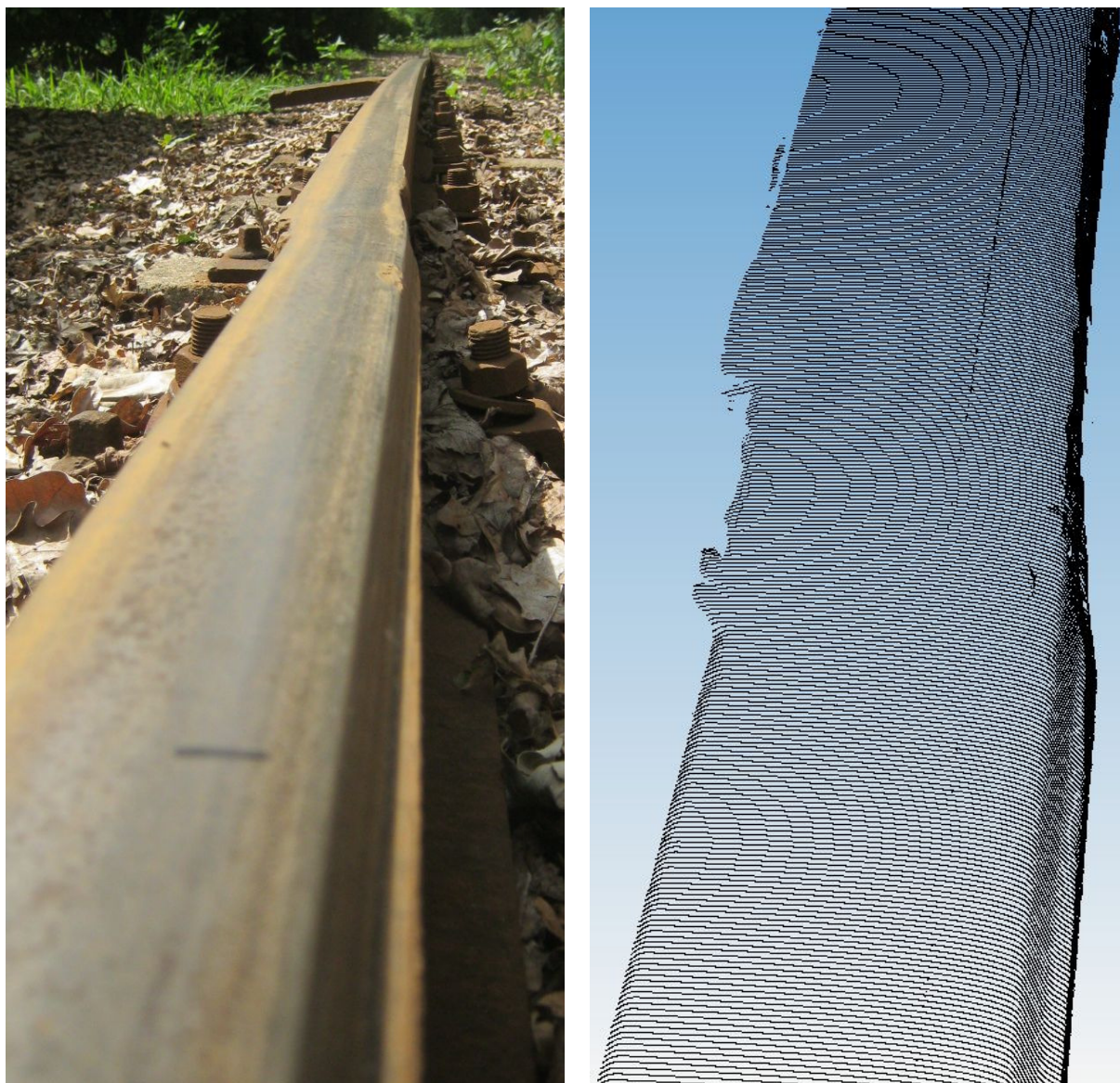
Rys.17. Widok rzeczywisty (z lewej) i cyfrowy bliźniak (z prawej) wadliwego połączenia szyn (widok zgodnie z kierunkiem jazdy)
