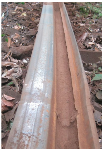
Rys.9. Widok rzeczywisty (z lewej) i cyfrowy bliźniak (z prawej) szyny toku wewnętrznego łuku o promieniu R=27 m toru wyjazdowego z pętli Park Pd. (widok zgodny z kierunkiem jazdy)
