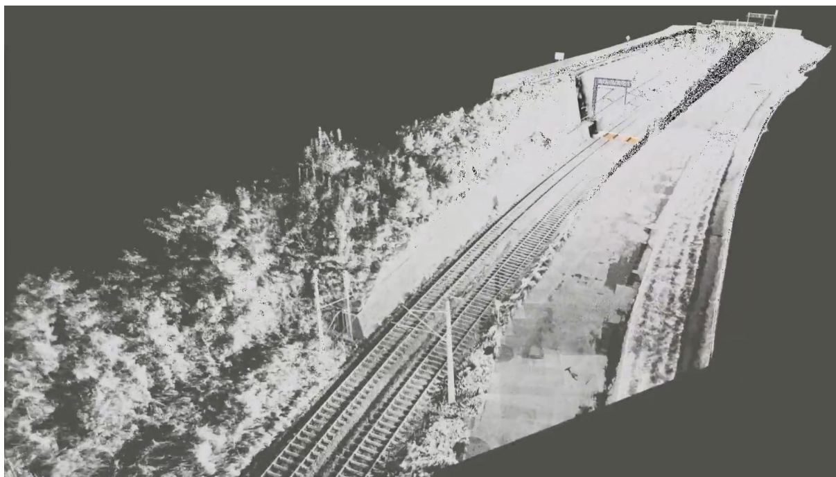
Rys.2. Przykład skanowania laserowego linii kolejowej wykonanego z drona [5]
