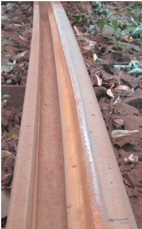
Rys.10. Widok rzeczywisty (z lewej) i cyfrowy bliźniak (z prawej) szyny toku zewnętrznego łuku o promieniu R=27 m toru wyjazdowego z pętli Park Pd. (widok zgodnie z kierunkiem jazdy)
