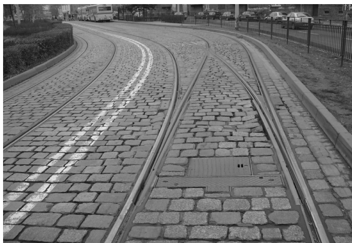
Fot. 4. Widok na analizowaną zwrotnicę zgodnie z kierunkiem jazdy
