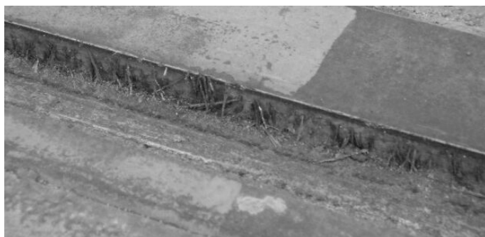
Fot. 2. Ścinanie ostrych górnych krawędzi rowka
