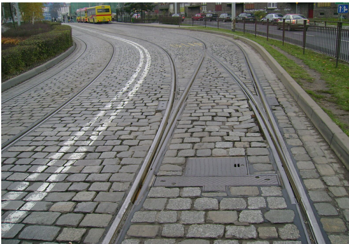
Fot.1 Widok na analizowaną zwrotnicę zgodnie z kierunkiem jazdy
