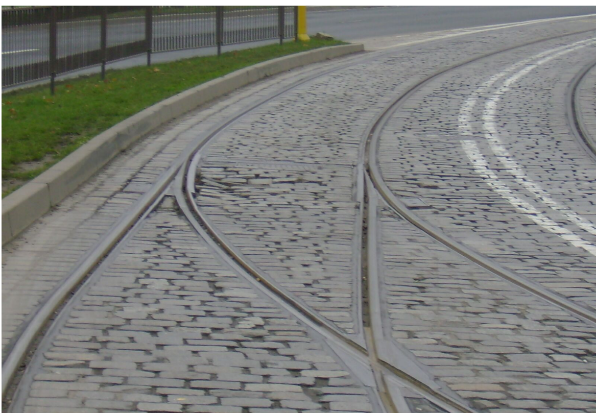
Fot.2 Widok na analizowaną zwrotnicę przeciwnie do kierunku jazdy
