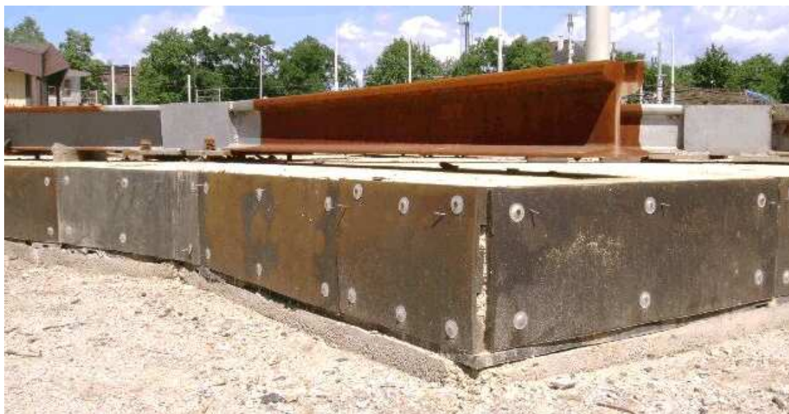
Fot. 8. Maty wibroizolacyjne z pełnej gumy z okrągłymi wydrążeniami umieszczone pod i po bokach podbudowy rozjazdu z betonu cementowego
