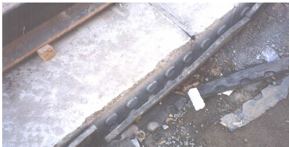
Fot. 5. Beton wypełniający wydrążenia mat wibroizolacyjnych
