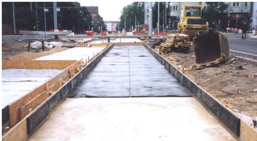
Fot. 3. Maty wibroizolacyjne z granulatu obłożonego płaszczem gumowym tworzące koryto pod i po bokach podbudowy toru z betonu cementowego
