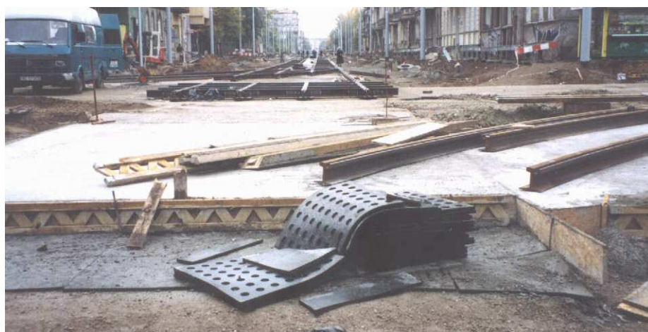
Fot. 4. Maty wibroizolacyjne z pełnej gumy z okrągłymi wydrążeniami tworzące koryto pod i po bokach podbudowy toru z betonu cementowego
