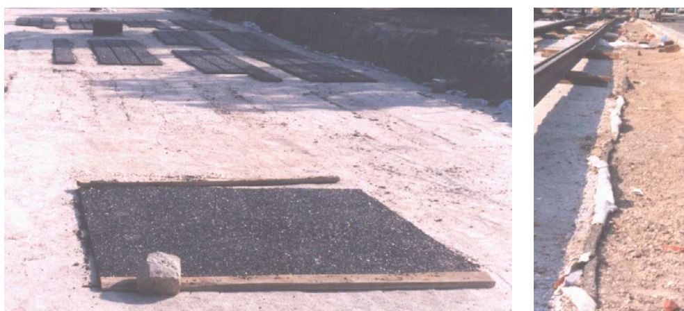
Fot. 1. Maty wibroizolacyjne z granulatu gumowego wykonane na budowie (z lewej) i po wbudowaniu w podtorze (z prawej)
