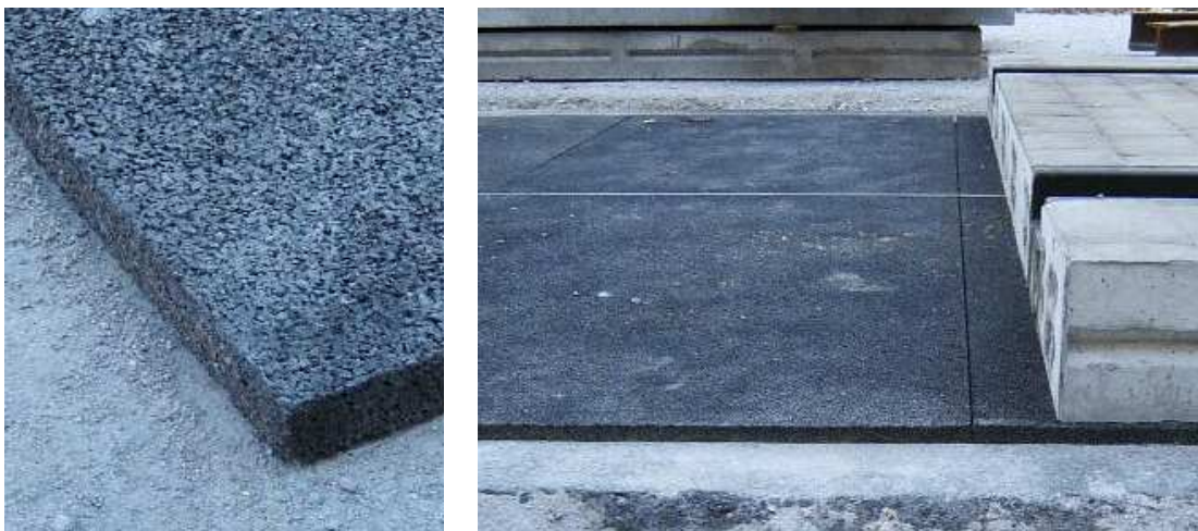
Fot. 7. Maty wibroizolacyjne z granulatu gumowego umieszczone pod płytami toru węgierskiego
