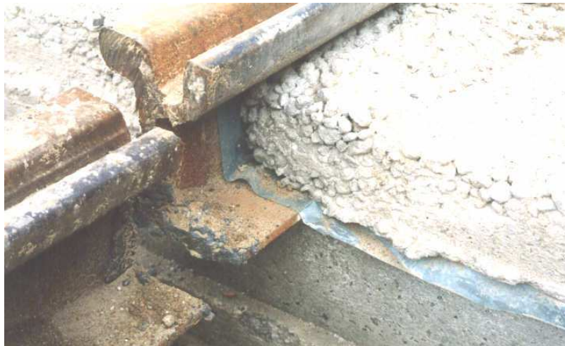
Rys.4 Wypełnienie komór szynowych betonem zabudowy śródtorza i międzytorza (Łódź - skrzyżowanie ul. Legionów i Zachodniej, rok 2002)
