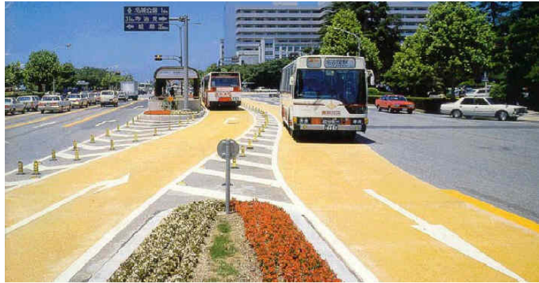
Rys.9 Nagoja - pasy autobusowe o nawierzchni w odmiennym żółtym kolorze [8]
