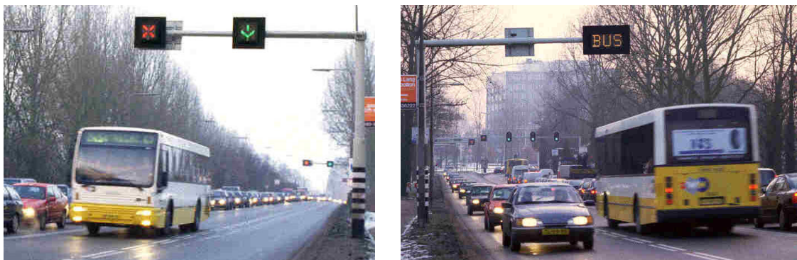
Rys.10 Utrecht - pas autobusowy wydzielony sygnalizacją świetlną i aktywnym oznakowaniem pionowym [9]
