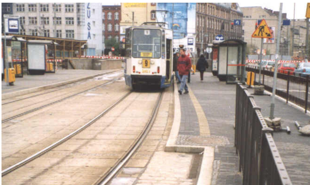
Rys.22 Niewłaściwy przebieg krawężnika - PAT na pl. Dominikańskim
