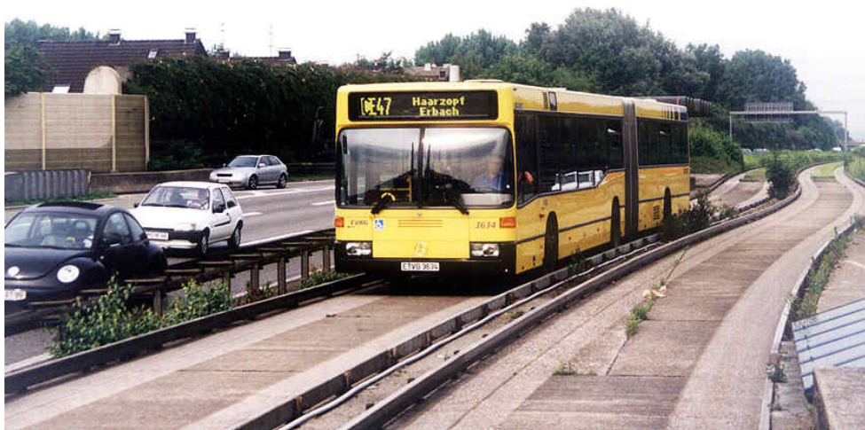
Rys.8 Essen - pas autobusowy o niekonwencjonalnej nawierzchni [7]
