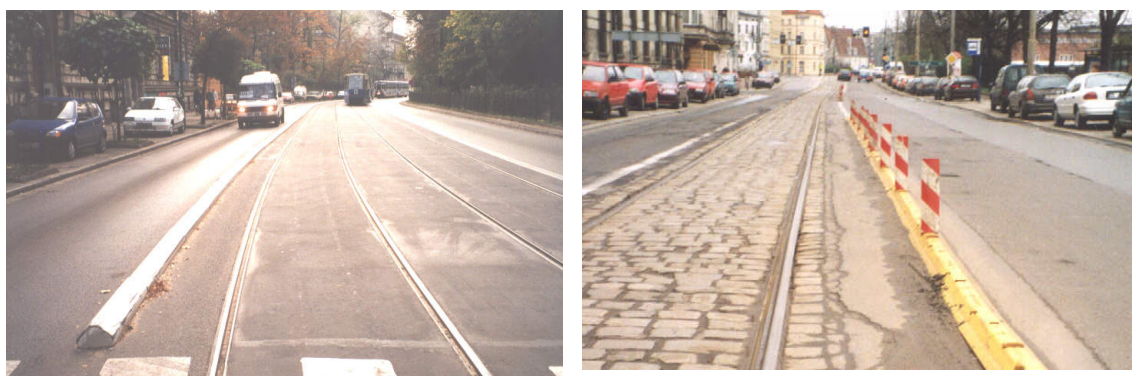
Rys.5 Wydzielenie torowiska separatorem: Kraków (z lewej) i Wrocław (z prawej)
