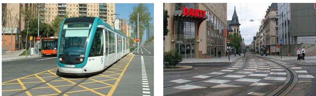
Rys.9 Odmienny sposób oznakowania poprzecznych przejazdów przez pasy ruchu przeznaczone wyłącznie dla pojazdów KZ: Barcelona (z lewej) i Nancy (z prawej)
