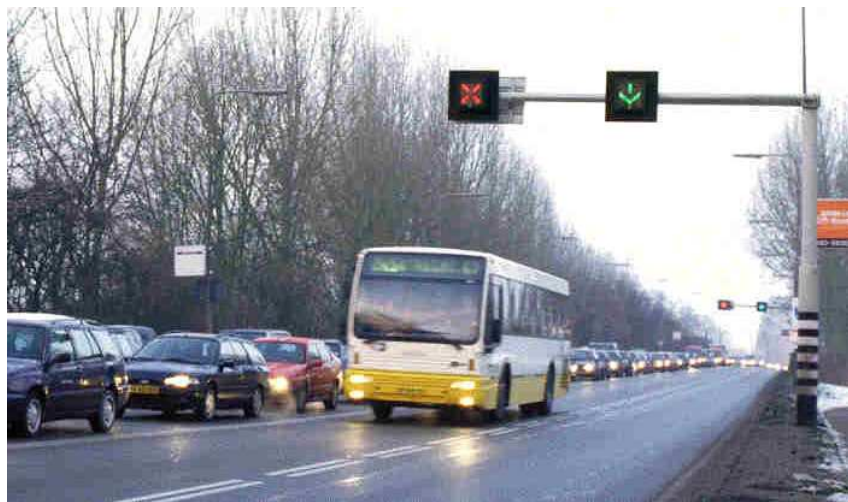
Rys.10 Utrecht - tymczasowy wydzielony sygnalizacją świetlną pas autobusowy pod prąd [7]
