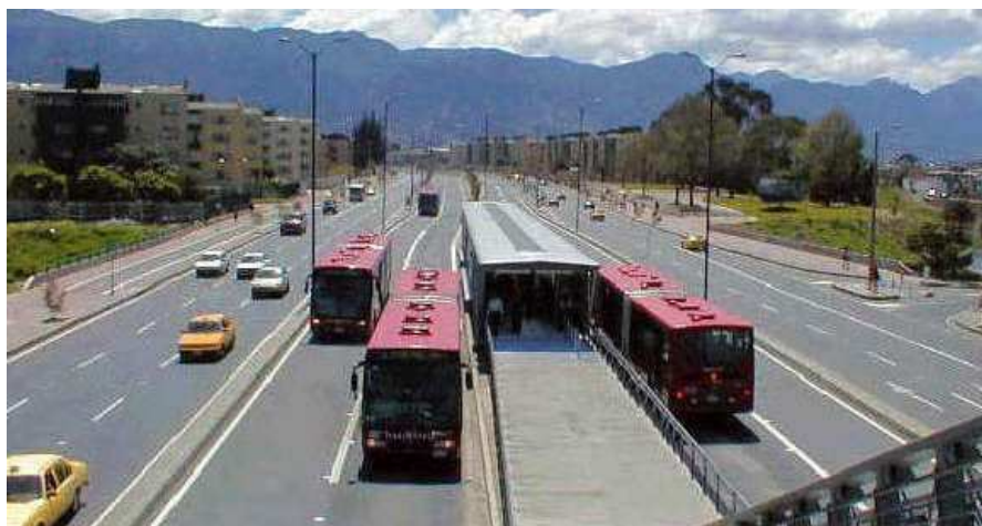
Rys.11 Bogota - dwa równoległe wydzielone pasy autobusowe w każdym kierunku [4]
