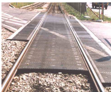
Rys.7. Gumowe płyty przejazdowe
