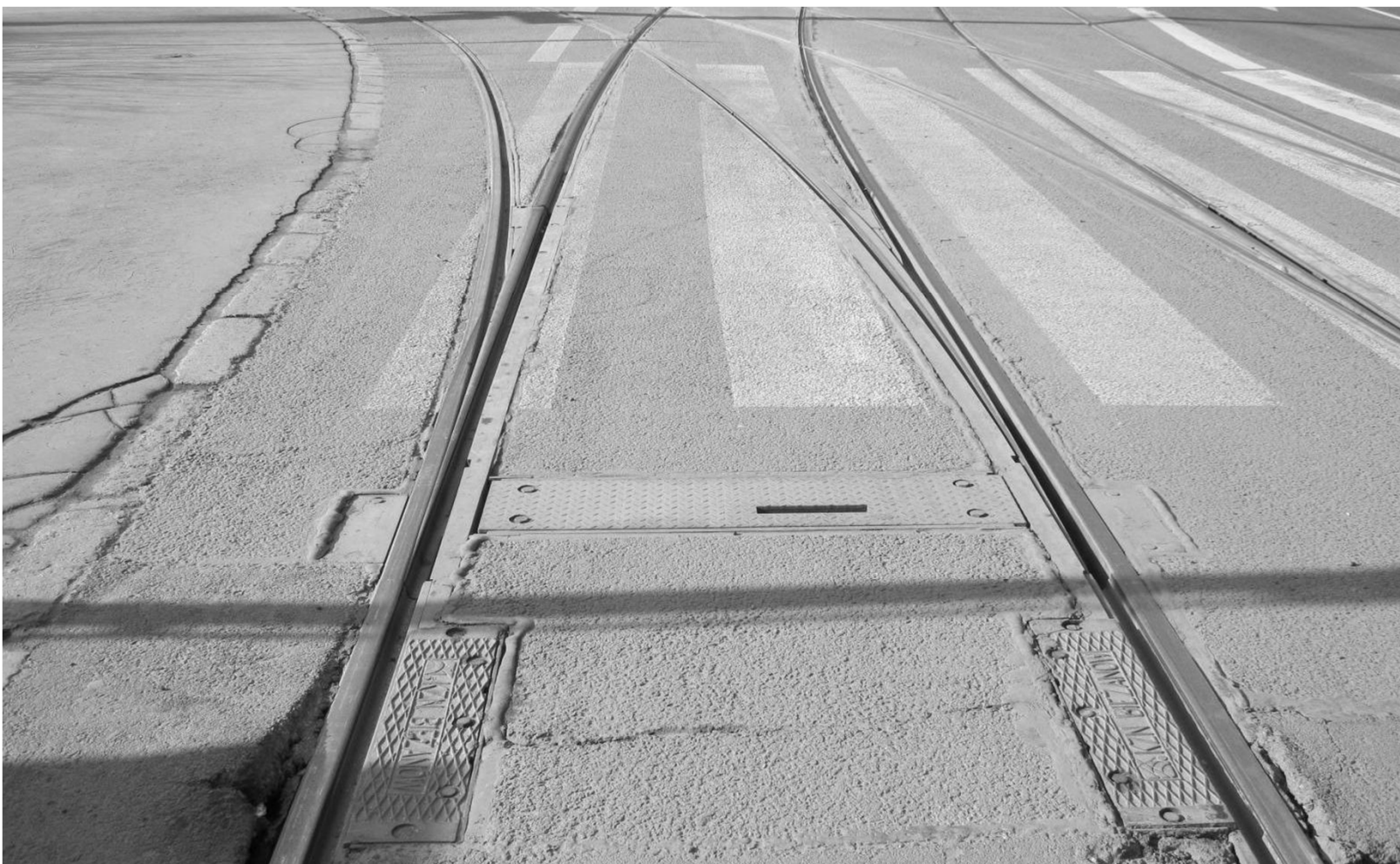
Wrocław, ul. Borowska / Dyrekcyjna – wylot południowy (do wakacji 2016) (niespełniony wymóg braku pokrywania się iglicy z przejściem dla pieszych – ale jest to zwrotnica zjazdowa)
